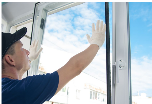
Colocación del acristalamiento.
