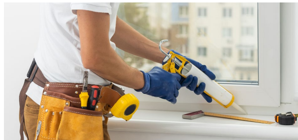
Sellado interior con silicona.
