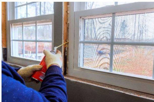
Sellado intermedio con espuma de poliuretano.
