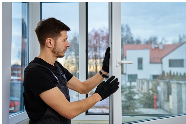
Comprobación de funcionamiento de hojas móviles.
