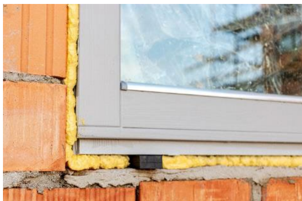
Sellado intermedio con espuma de poliuretano.
