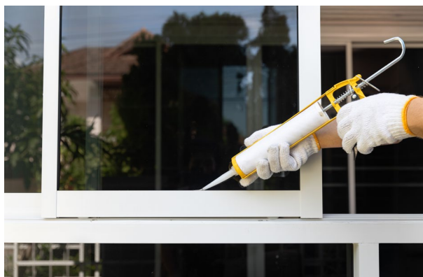
Sellado de acristalamientos con silicona.
