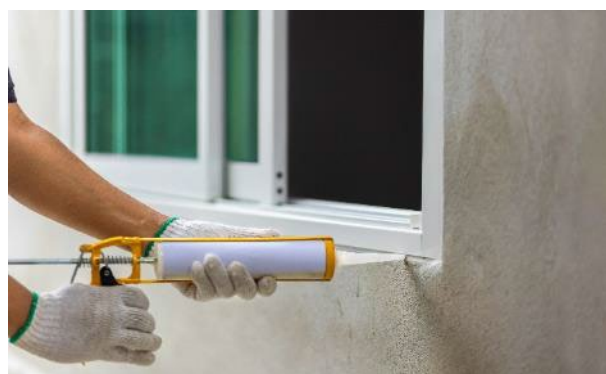
Sellado exterior con silicona.
