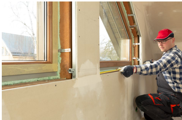
Fijación con patillas al precerco
