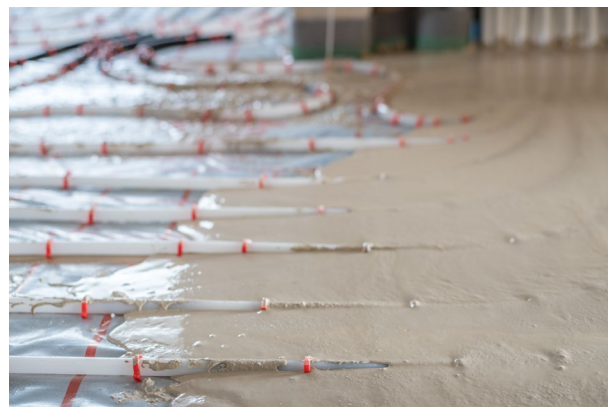
Solera de mortero autonivelante
