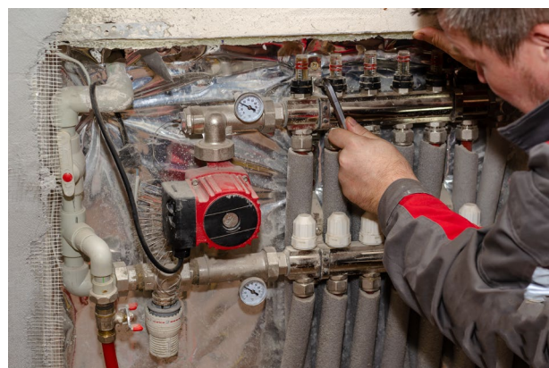
Ajuste de caudalímetros
