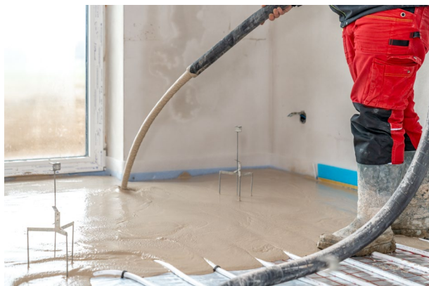
Vertido de mortero autonivelante
