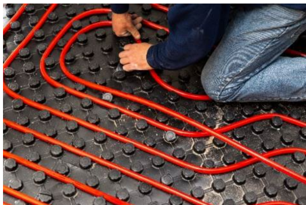
Fijación de tubería sobre tetones
