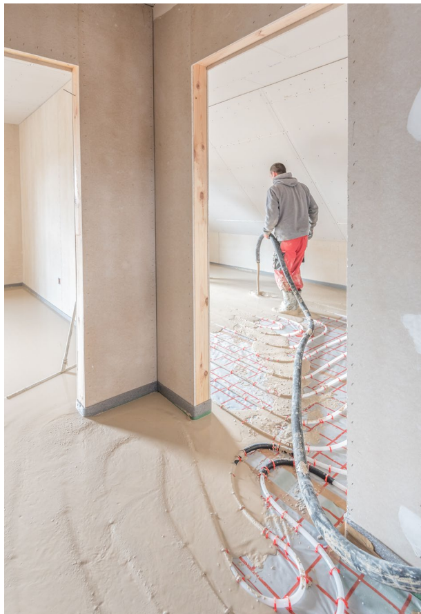
Solera autonivelante. Vertido
