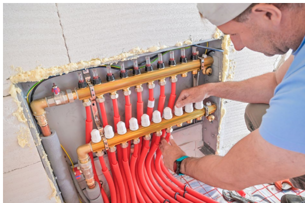
Instalación del colector de calefacción
