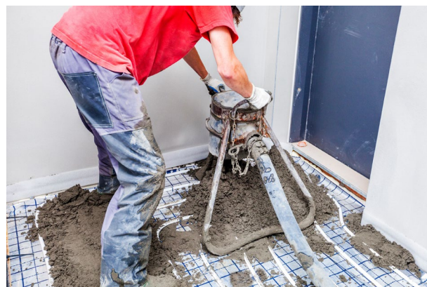
Solera de mortero de cemento y arena. Vertido
