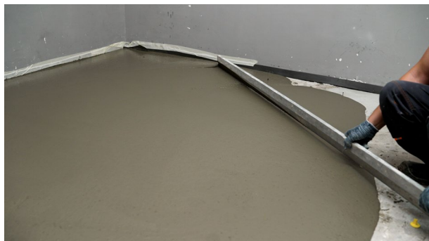
Nivelación de superficie de forjado
