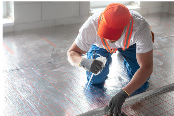
Fijado de juntas de paneles lisos mediante cinta adhesiva
