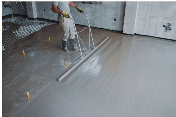
Vertido y nivelación de capa de mortero
