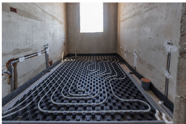
Paneles de sistemas de tetones encajados de forma continua
