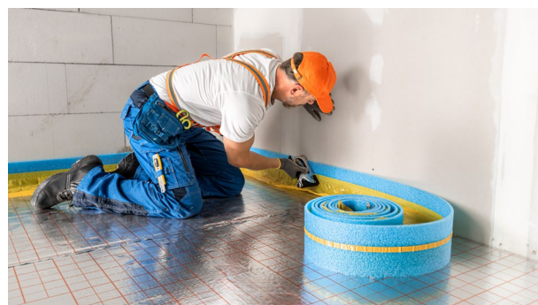
Colocación de la banda perimetral
