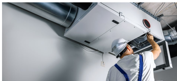
Verificación de la unidad interior
