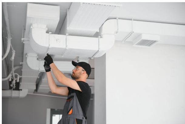
Verificación de conductos y rejillas
