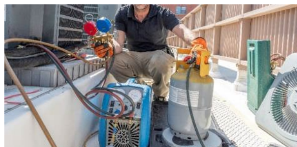
Recuperación de gas refrigerante
