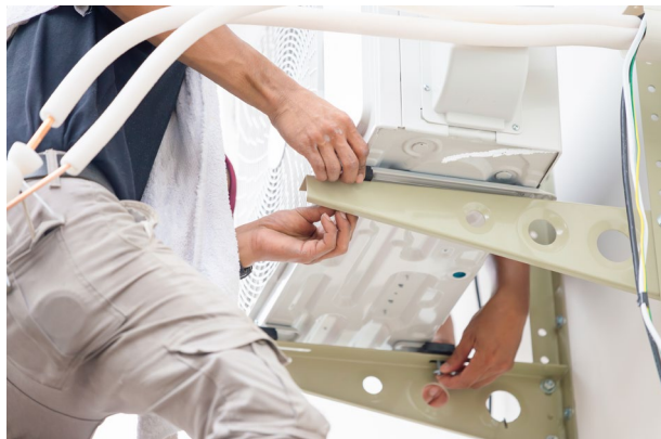
Colocación de la unidad exterior en el soporte
