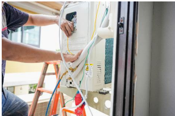
Conexión eléctrica entre unidades
