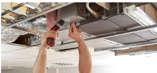
Montaje de la unidad interior
