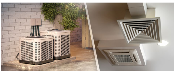
Unidad exterior, unidad interior y conductos
