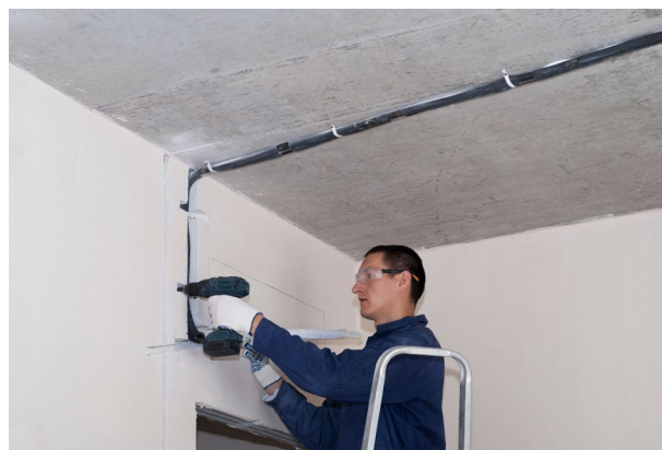
Tender líneas de refrigerante
