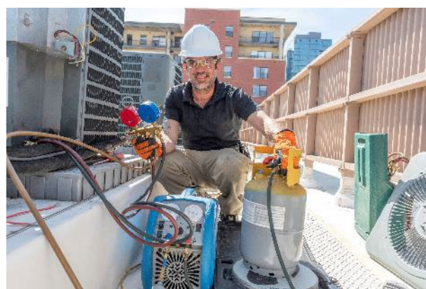
Recuperación del refrigerante
