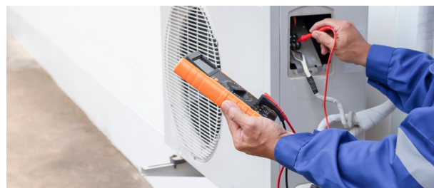
Comprobar continuidad eléctrica
