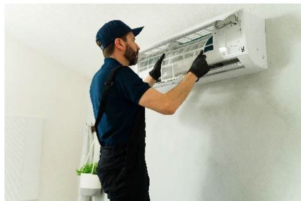
Limpieza de filtros
