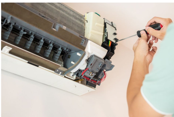
Ajuste de conexiones eléctricas
