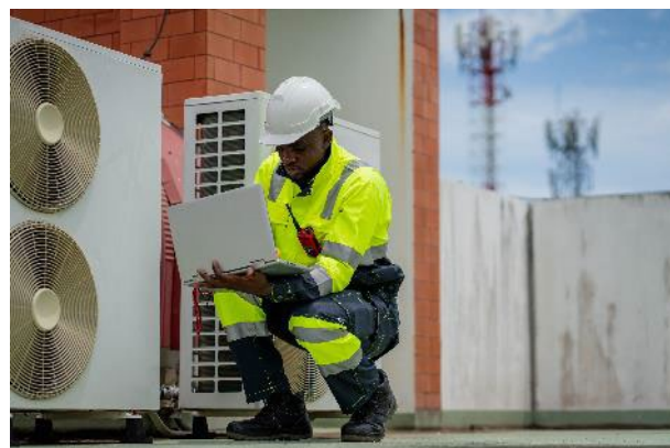
Tareas de verificación y mantenimiento de la bomba de calor
