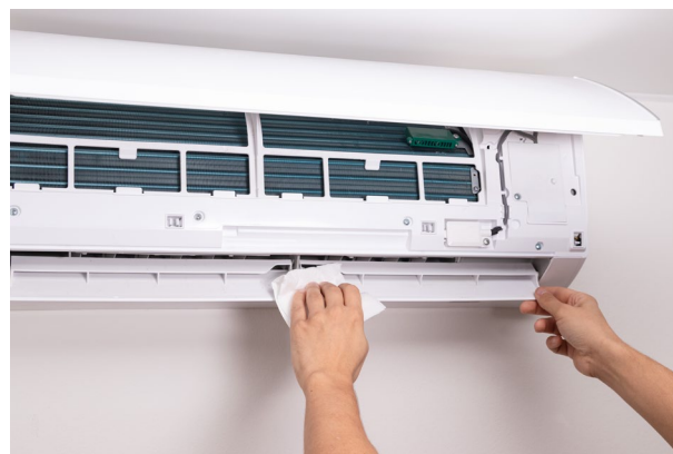
Limpieza de las rejillas de impulsión
