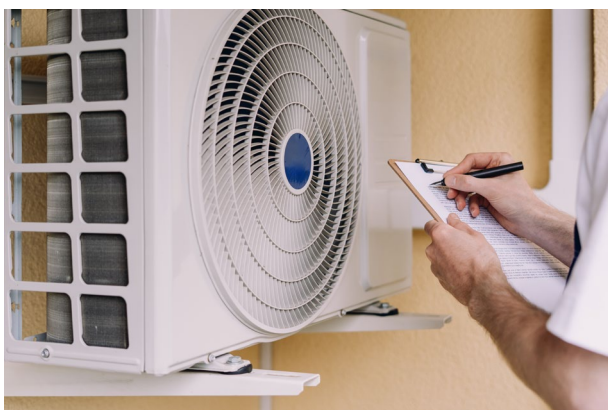
Verificación de la unidad exterior
