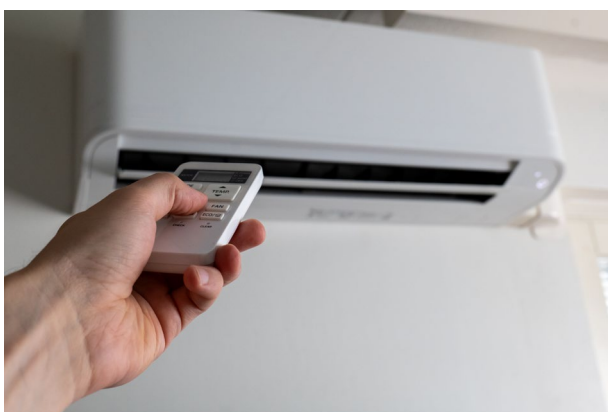
Verificación del termostato
