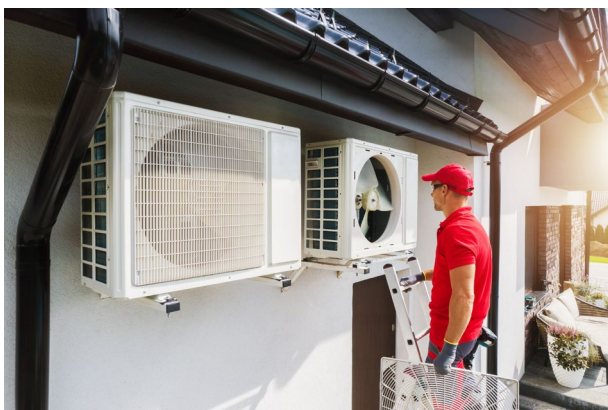
Verificación del estado de las aletas y limpieza
