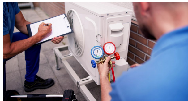
Verificación de presiones del circuito
