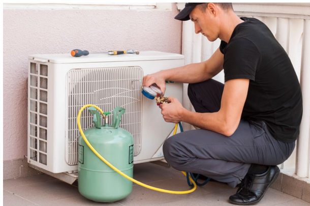
Recarga de gas refrigerante
