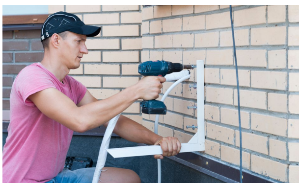
Colocación de soportes
