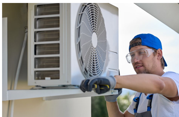
Fijación de la unidad exterior
