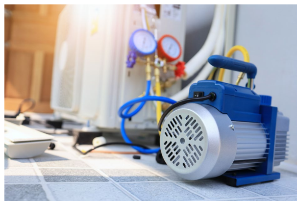
Vaciado del circuito con bomba de vacío
