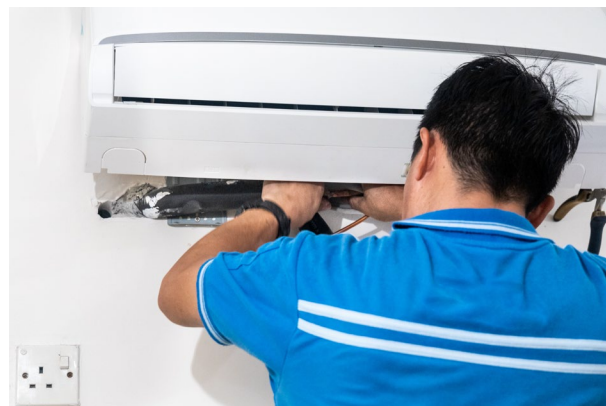
Conexión de tuberías
