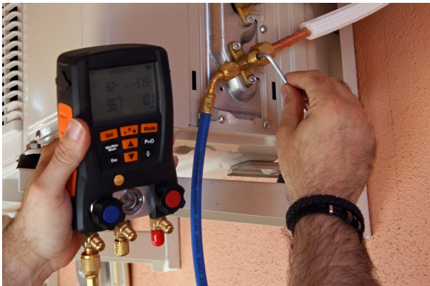
Comprobación del sistema para su puesta en marcha
