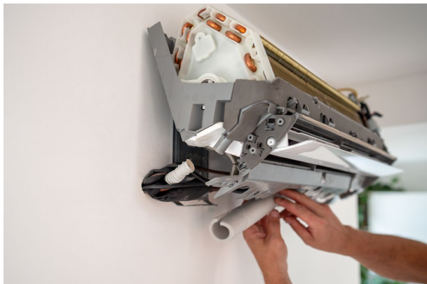
Conexión de tuberías
