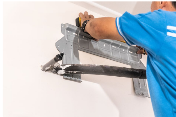
Instalación de placa de sujeción mural nivelada
