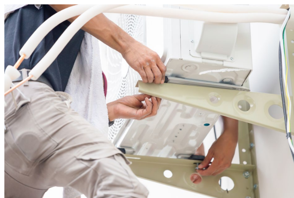
Colocación de la unidad sobre los soportes
