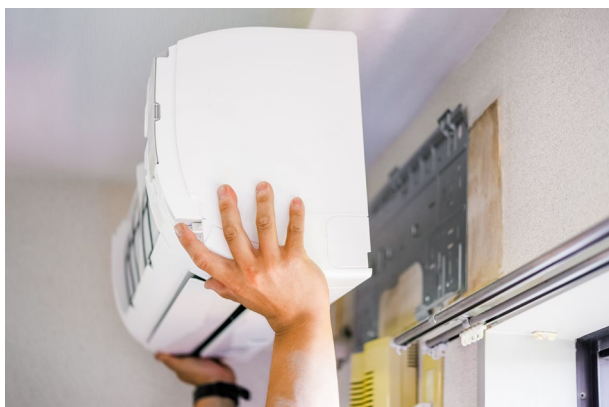
Colocación de la unidad sobre la placa
