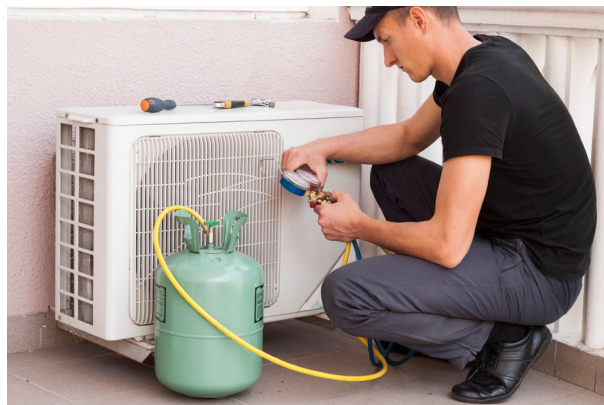
Recarga de gas refrigerante
